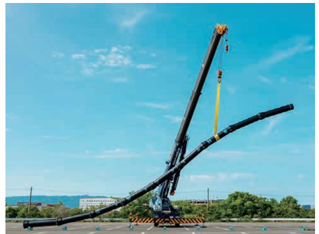
GX 形ダクタイル鉄管の吊り上げ
