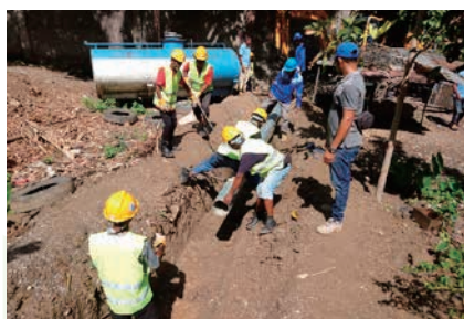
水道管工事の指導
