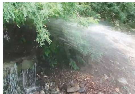
配水管の大規模漏水
