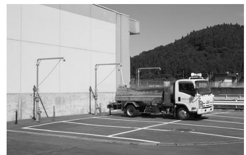
図2 茂庭浄水場 給水車用注水補給設備
