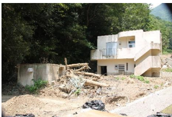
土砂が流入し、機能が停止した愛媛県南予水道企業団吉田浄水場
