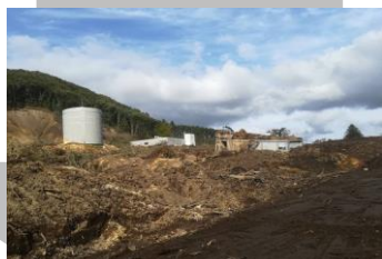
土砂流入により、全壊した北海道厚真町富里浄水場
