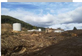
土砂流入により、全壊した北海道厚真町富里浄水場
